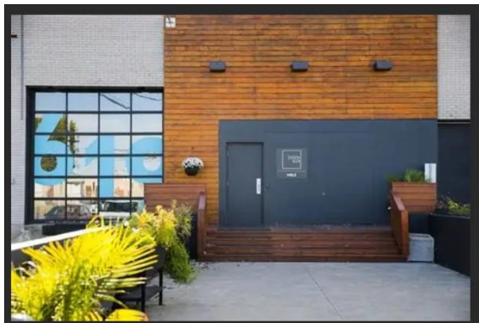
Porte d'entrée à l'arrière de l'édifice
